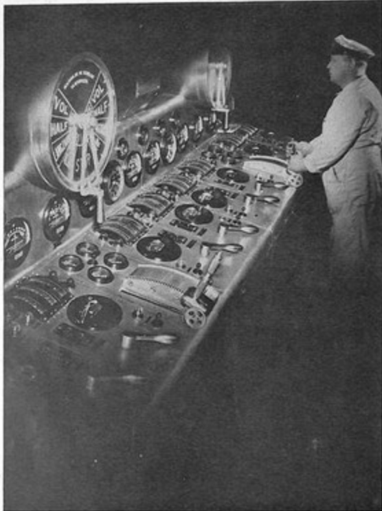
Afb. 94 De centrale manoeuvreerstand
