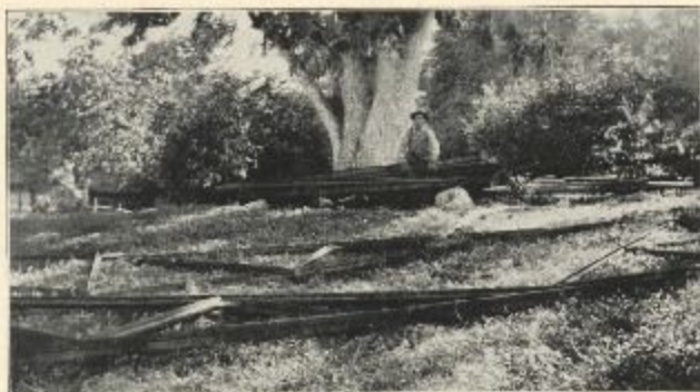
Constructiewerk voor den aanleg der elektrische centrale te Manokwari. Noord Nieuw-Guinea.
