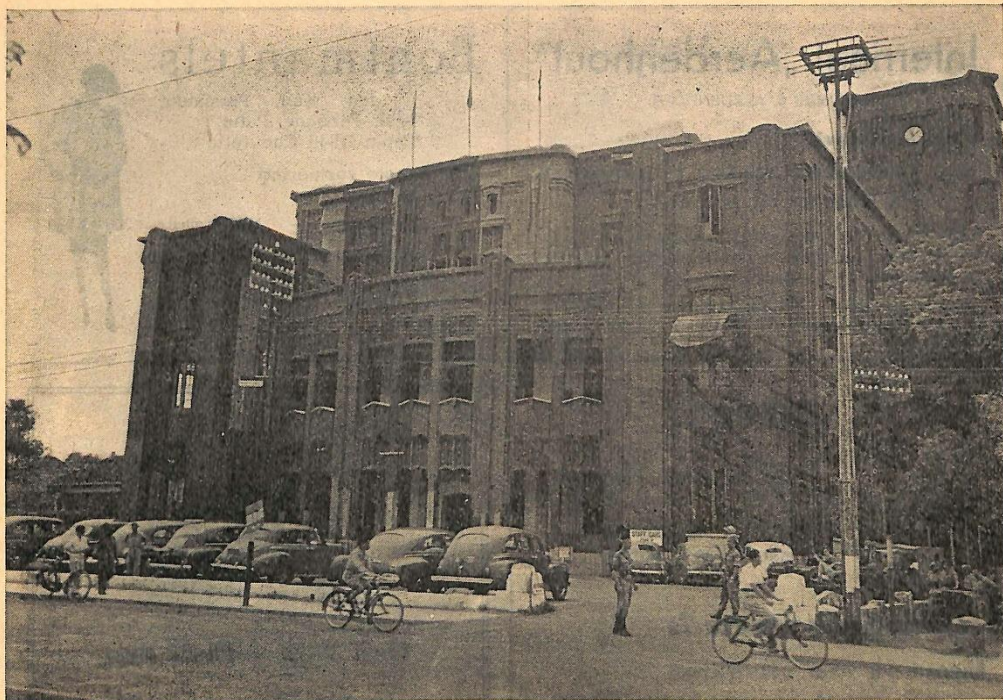
Een der voornaamste gebouwen van Batavia. Het gebouw der Koninklijke Paketvaart Maatschappij te Batavia — de tekst der officiële foto spreekt wel zeer ten onrechte van „het voormalige KPM-gebouw”. — Thans is daar „HQ-A.F.N.E.I.” gevestigd, hetgeen beteekent het hoofdkwartier der geallieerde troepen.
