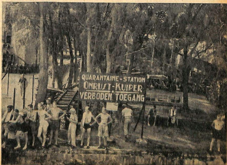
De aanlegsteiger op het eiland Onrust.
