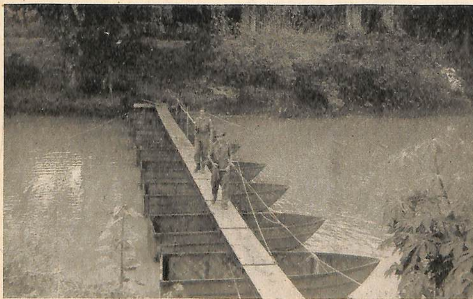
Onze troepen in Indië zijn ook in het pionierswerk bedreven. Bovenstaande pontonbrug over de Mookervaart bij Tangerang sloegen zij in anderhalf uur.
