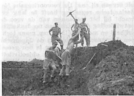
Een tankval in den weg van Batavia naar Tangerang wordt door Nederl. genietroepen dichtgeworpen.
