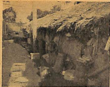
Buiten-aanzicht van een der woonhutten. Wasch- en keuken-gerei staan buiten.
