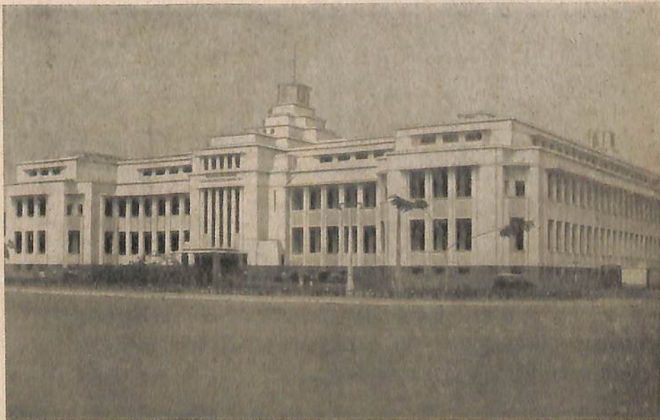
GEBOUW DER NEDERLANDSCHE HANDEL MAATSCHAPPIJ TE BATAVIA.
