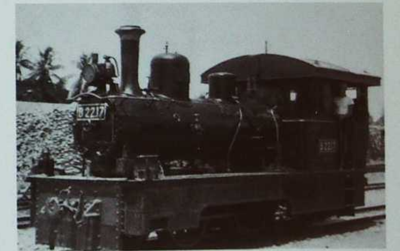
Locomotief van de serie 306-325 van de Nederlandsch-Indische Spoorweg Maatschappij met na-oorlogs nummer. Het vooroorlogse nummer was 312. Indienststelling 1899-1901.
