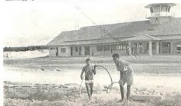
Kabellegging voor het nieuwe stationsgebouw Mokmer.
