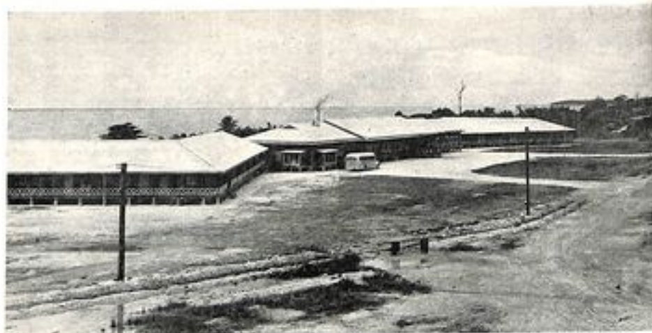
Het nieuwe KLM-hotel, „I Rii“, te Bink, gezien vanuit de contrôle-toren van het nog in aanbouw zijnde stationgebouw. De bouwkosten van dit hotel, inclusief de inrichting heeft ongeveer 1,8 miljoen gulden gekost. Het hotel werd gebouwd door de Amsterdamse Ballast Maatschappij.
