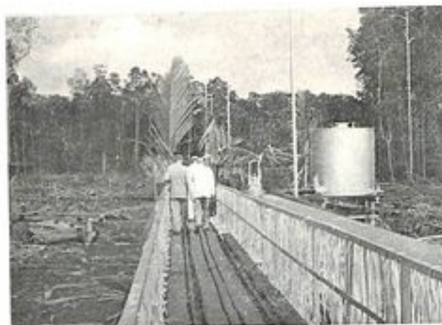
Het eindstation met de overvoertank.
