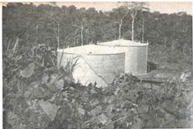
De opslagtanks te Temboeni.
