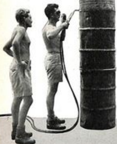
De laatste drum van de zaagvis-tank wordt vastgezet.
