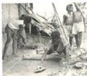
V.V.S.-jongens helpen bij de bouw van de school.
